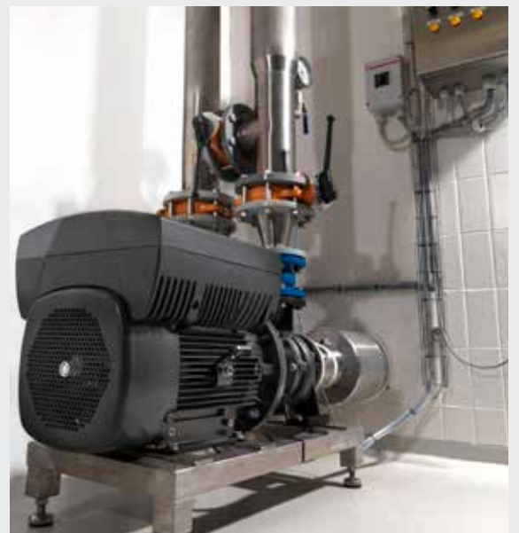
NBE E-pump ที่โรงงาน ARLA Foods Arinco ในประเทศเดนมาร์ก
