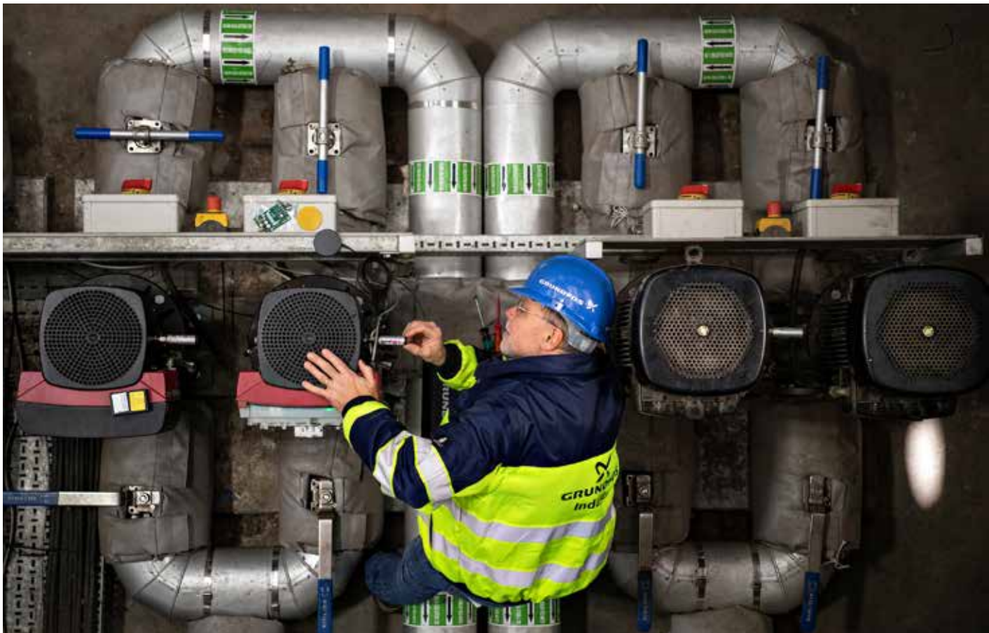
Michael Rasmussen ผู้จัดการอาวุโสฝ่ายการใช้งานของกรุนด์ฟอสกับหนึ่งในทีม CRE ใหม่สำหรับควบคุมระดับการจ่ายน้ำให้หม้อไอน้ำที่โรงกลั่น William Grant & Sons' Girvan Distillery ในประเทศสกอตแลนด์
