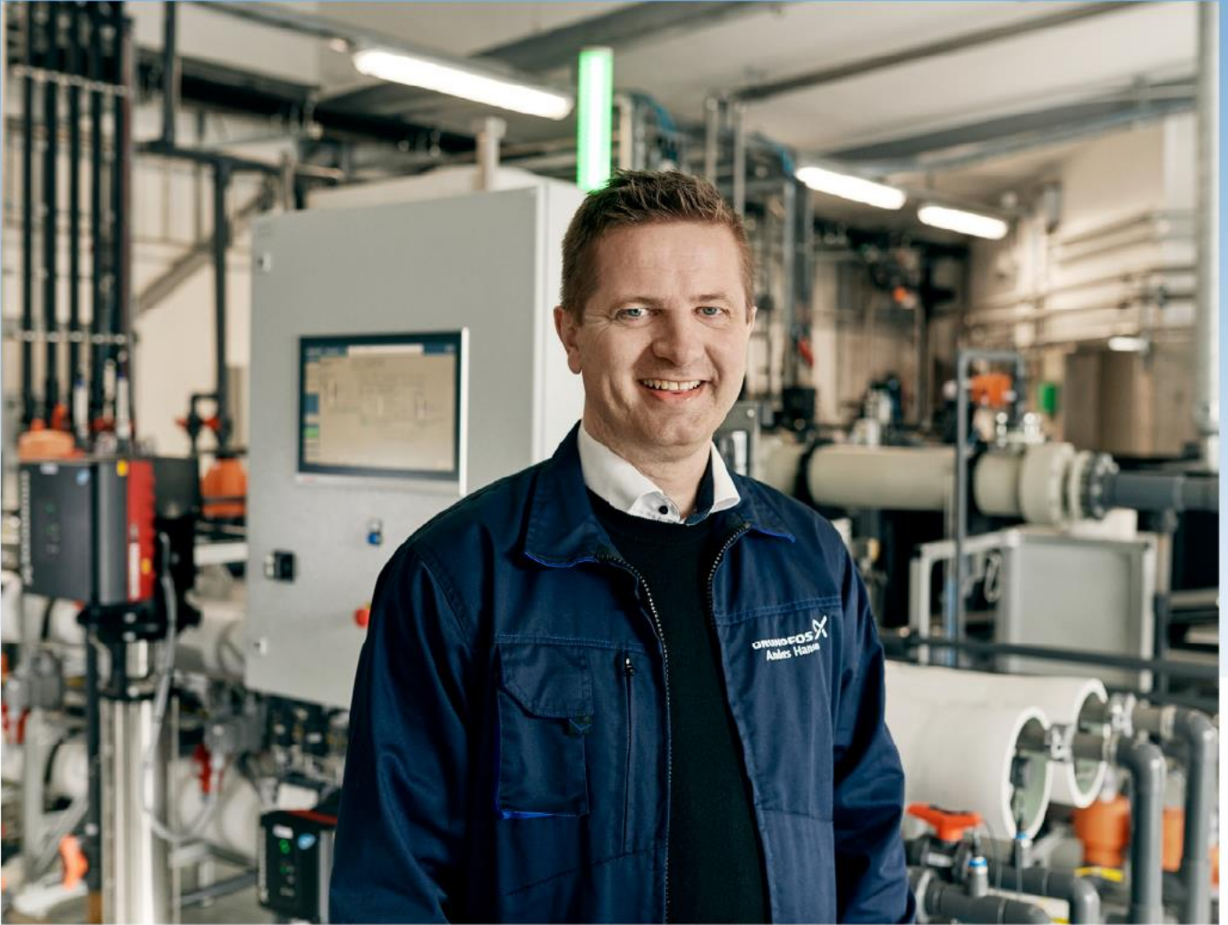
แอนเดอร์ส ลุนด์ แฮนเซน, ผู้อำนวยการอาวุโสฝ่ายการผลิต ที่กรุนด์ฟอส เมืองเบอร์ลิน ประเทศเดนมาร์ก ยืนอยู่ด้านหน้าของระบบบำบัดน้ำของโรงงาน เพื่อนำกลับมาใช้ใหม่
