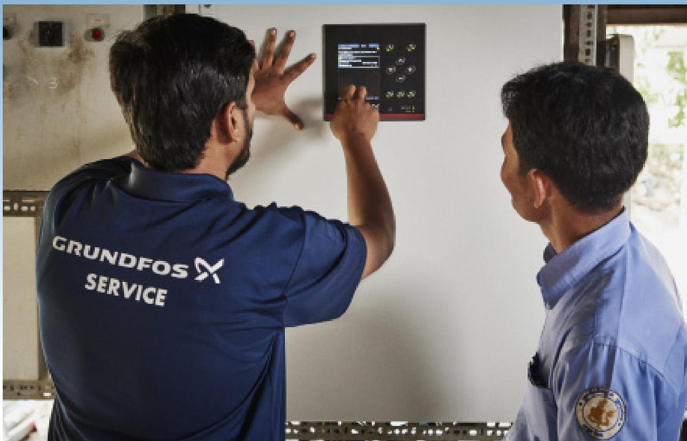
Karthik Balasubramaniam (图左) 与茶胶安全水供应公司的供水网络主管Em Eang一起检查CU 354控制器——“DDD”系统的核心部分。
