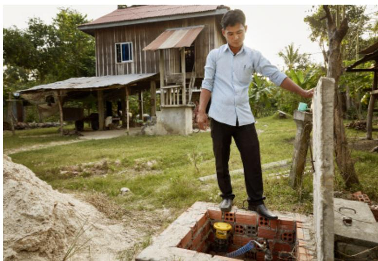
茶胶安全水供应公司的供水网络主管Em Eang在自来水厂供水网络的关键节点——距离工厂10公里的Prek Pha-Aov村检查远程传感器。传感器会收集每天的用水数据并将其传送回中央控制器以自动调节系统的负载曲线。
