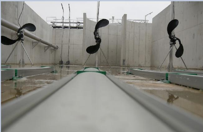
格兰富推流器的安装推进了托马舍夫市的废水池的现代化改造。
