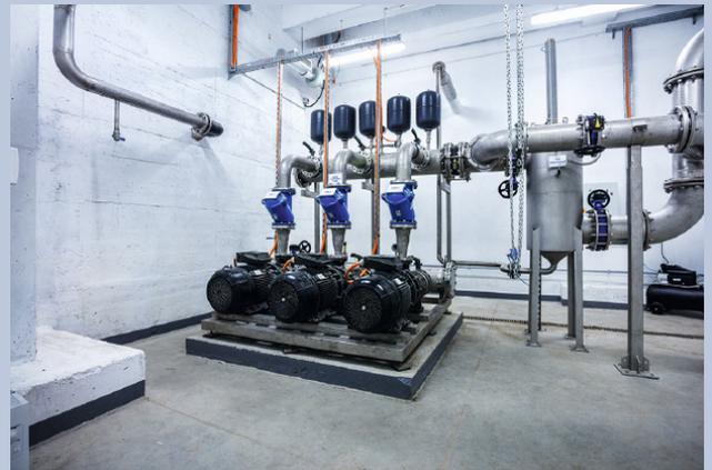
托马舍夫·马佐舍夫市的污水厂使用了格兰富Hydro MPC增压系统来进处理流程水。“我在波兰国内的所有项目均使用了这种格兰富设备。”Cadagua公司的合同经理Adam Bierut表示。
